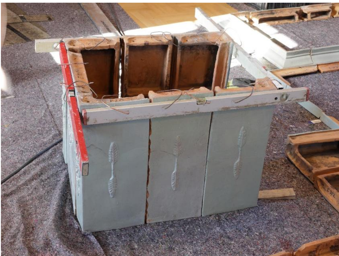
120-121. Postavená soklová část pece. Druhé poschodie vyskladané na podlahe.
