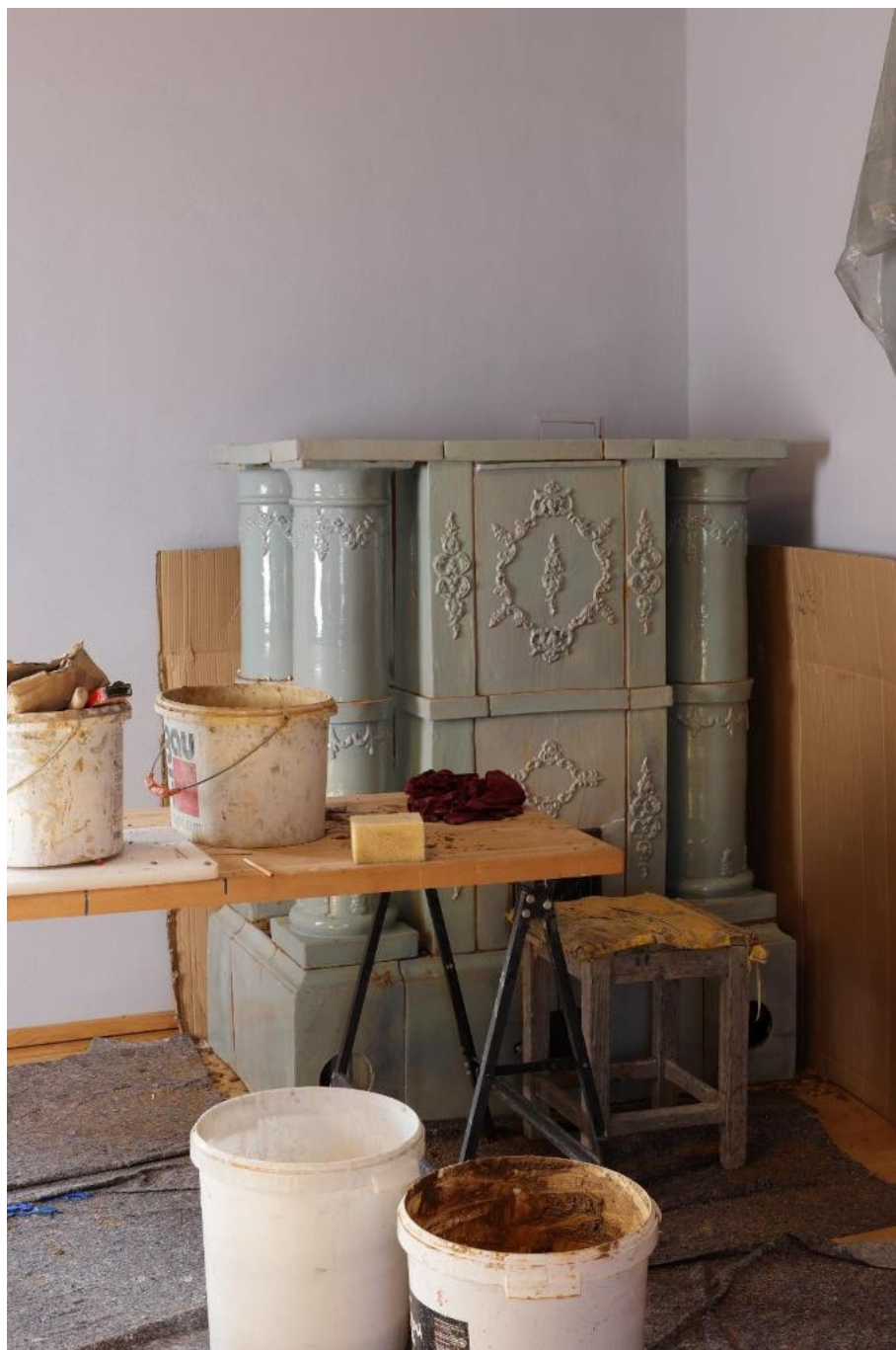
124. Už je postavená väčšia časť pece. Po jednotlivých poschodiach, bola vždy urobená prestávka, aby vybudovaná časť riadne spevnela.
