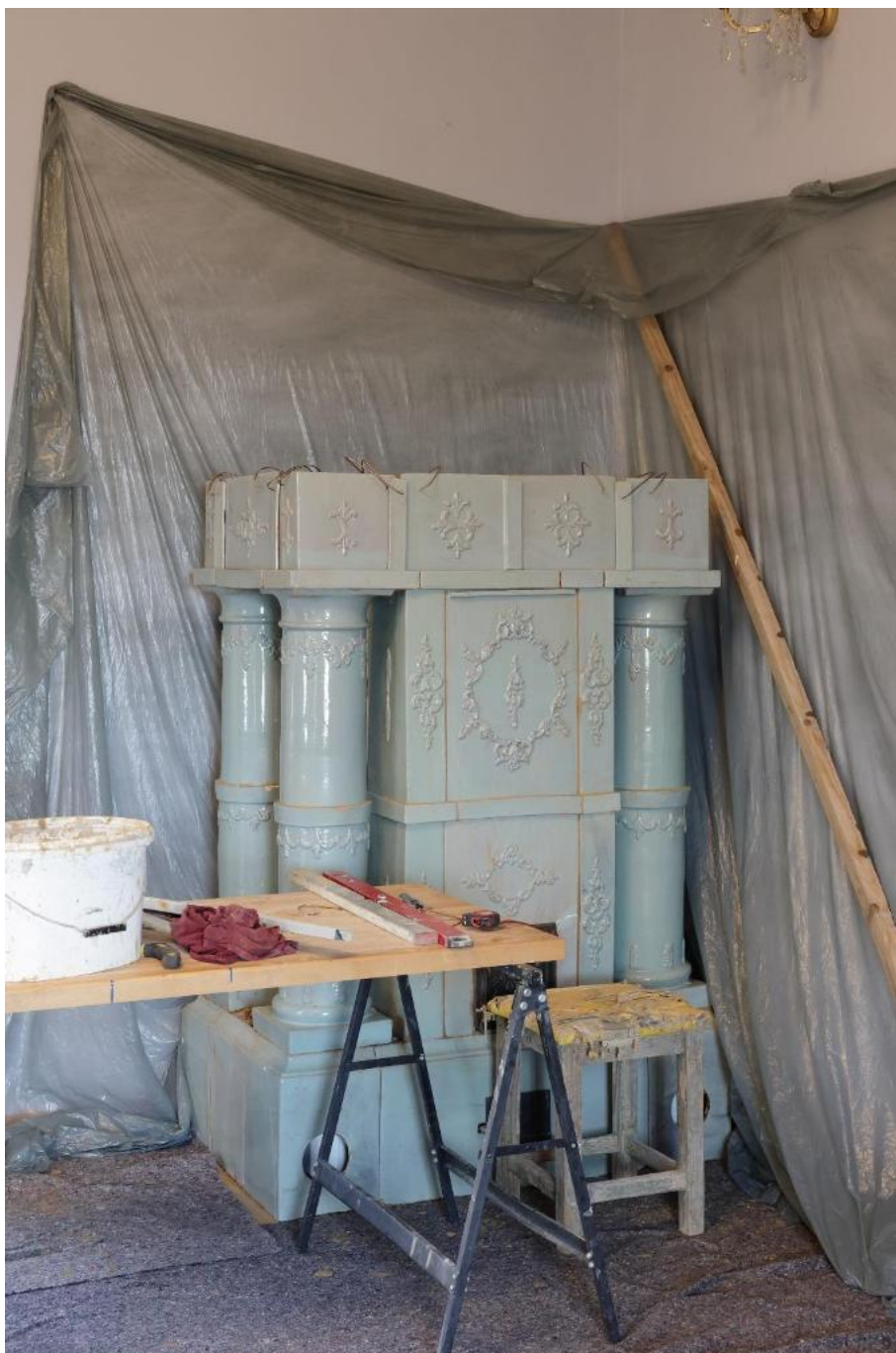
126. Budovanie prekladovej časti pece. Steny v krištáľovej miestnosti barokového paláca boli počas stavania chránené kartónmi a igelitom.
