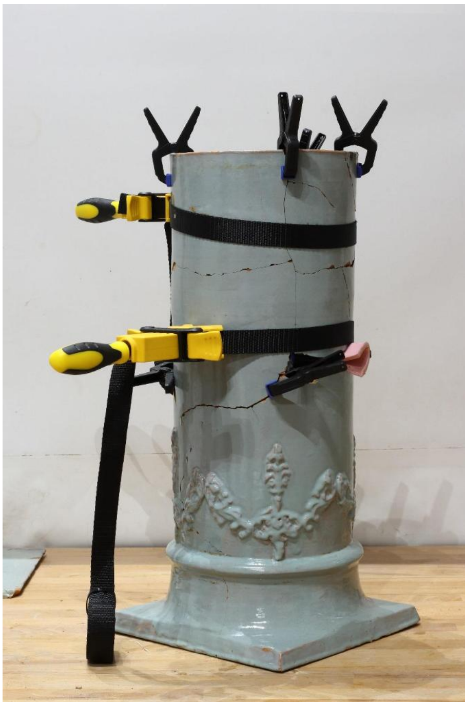
55. Zlepenie jednotlivých častí stĺpu do celku. Jednotlivé celky museli byť fixované viacerými svorkami.
