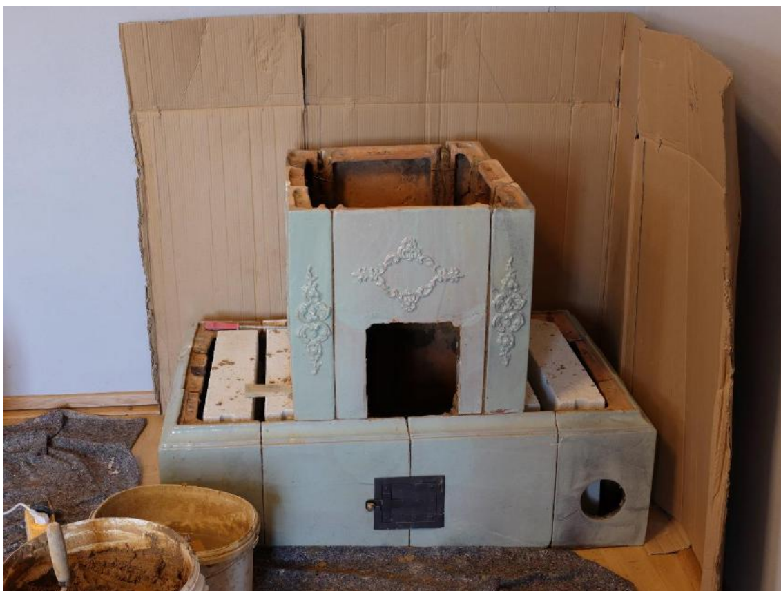
122. Postavené prvé dve poschodia pece. Vnútroňá časť je postavená s pórobetónových tvárníc. Tvárnice sú iba v spodnej časti pece a slúžia na rozloženie váhy pece a postavenie stĺpov. Pec je postavená iba ako múzejný exponát bez vnútroňých ťahov pece.
