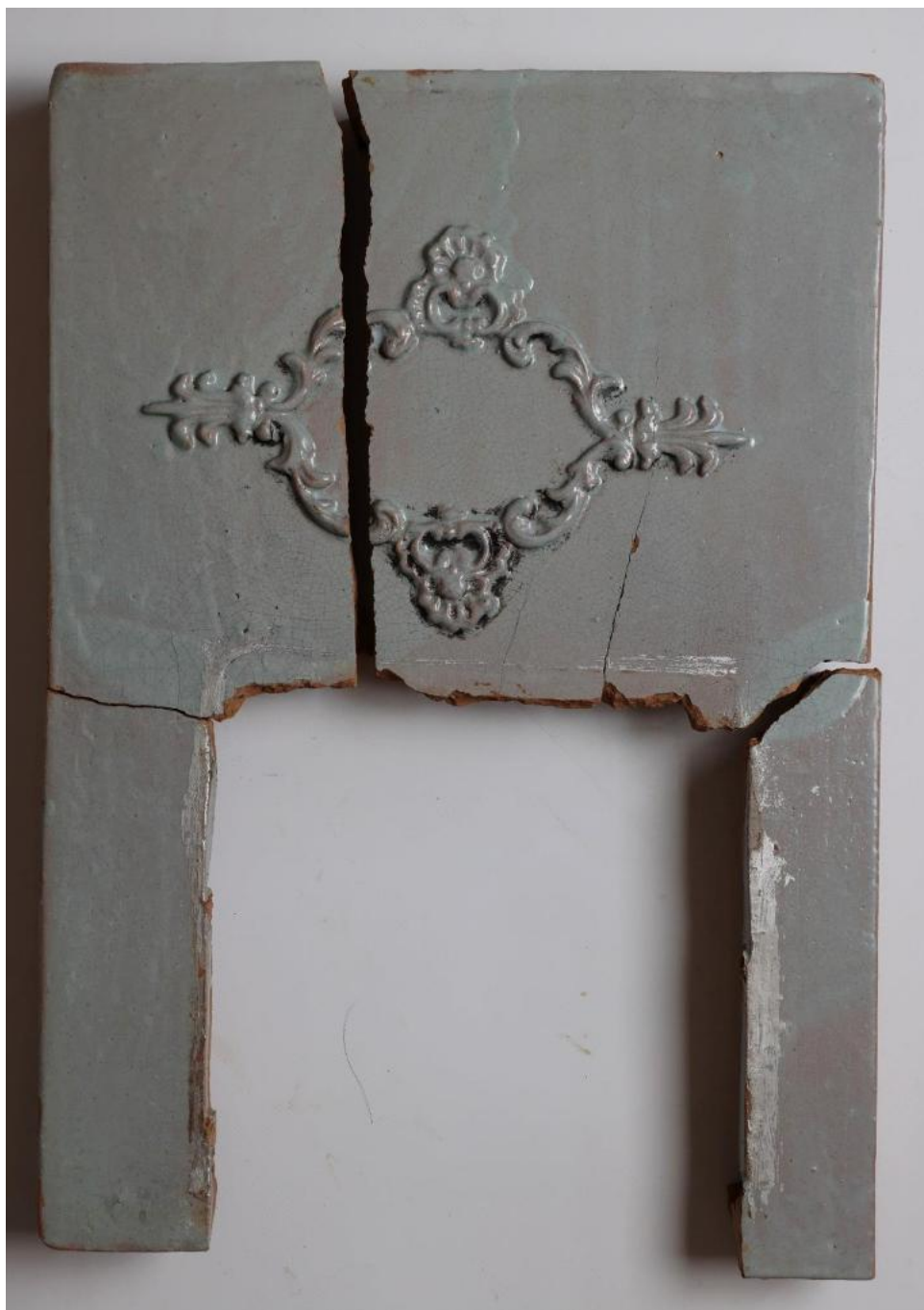
23. Kachlica s otvorom na kovové dvierka po očistení od kachliarskej hlíny a sadzí.
