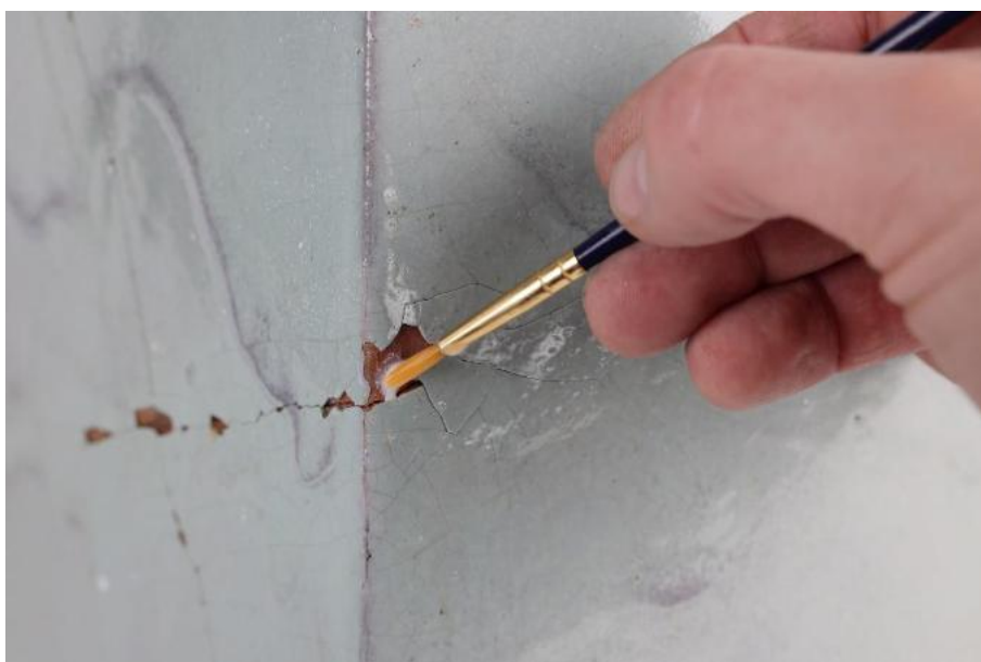
76-77. Uvoľnená glazúra bola spevnená disperzným lepidlom.
