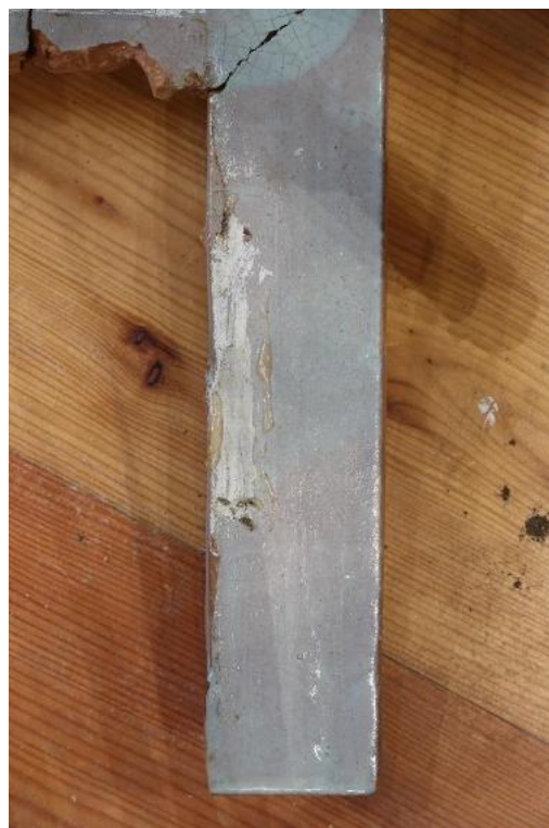
78. Čistenie kachlice s otvorom na dvierka od striebornej farby.
