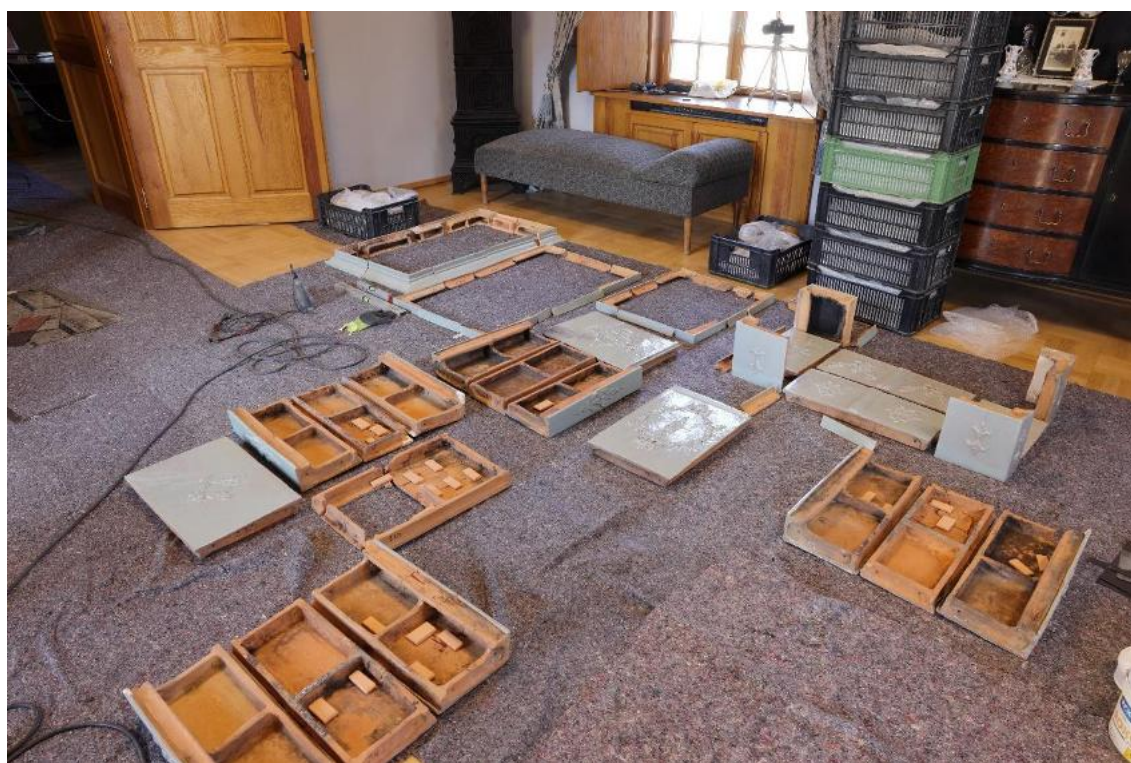
118-119. Kachlice rozložené v miestnosti barokového paláca na hrade Ľubovňa pred postavením. Kachlice boli roztriedené podľa jednotlivých poschodí.
