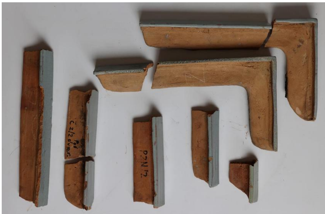
30. Viaceré malé kachlice, ktoré slúžili na prekrytia škáry medzi veľkými kachlicami boli polámané. Kachlice po očistení.
