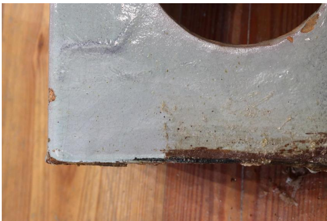
79. Čistenie soklovej kachlice od podlahového laku a hnedej farby pomocou odstraňovača starých náterov.
