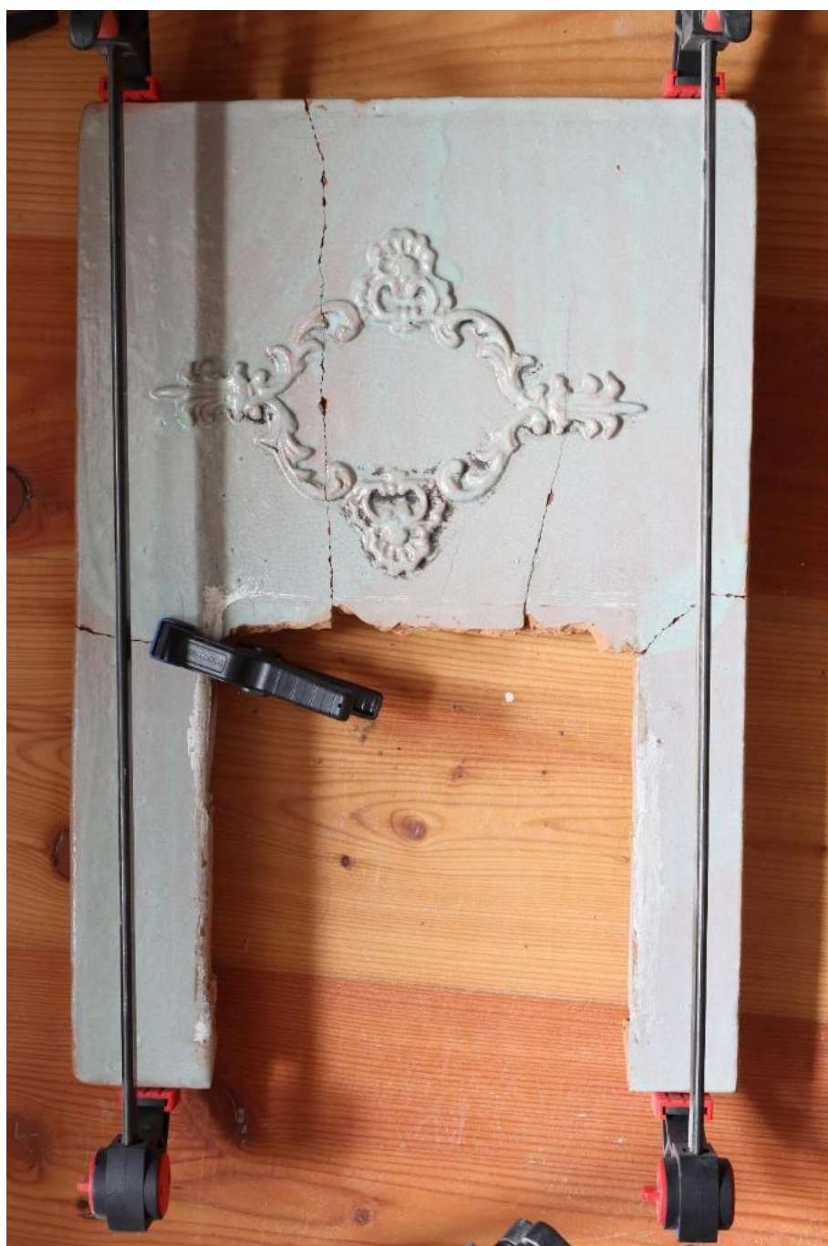
61. Lepenie kachlice s otvorom na kovové dvierka.
