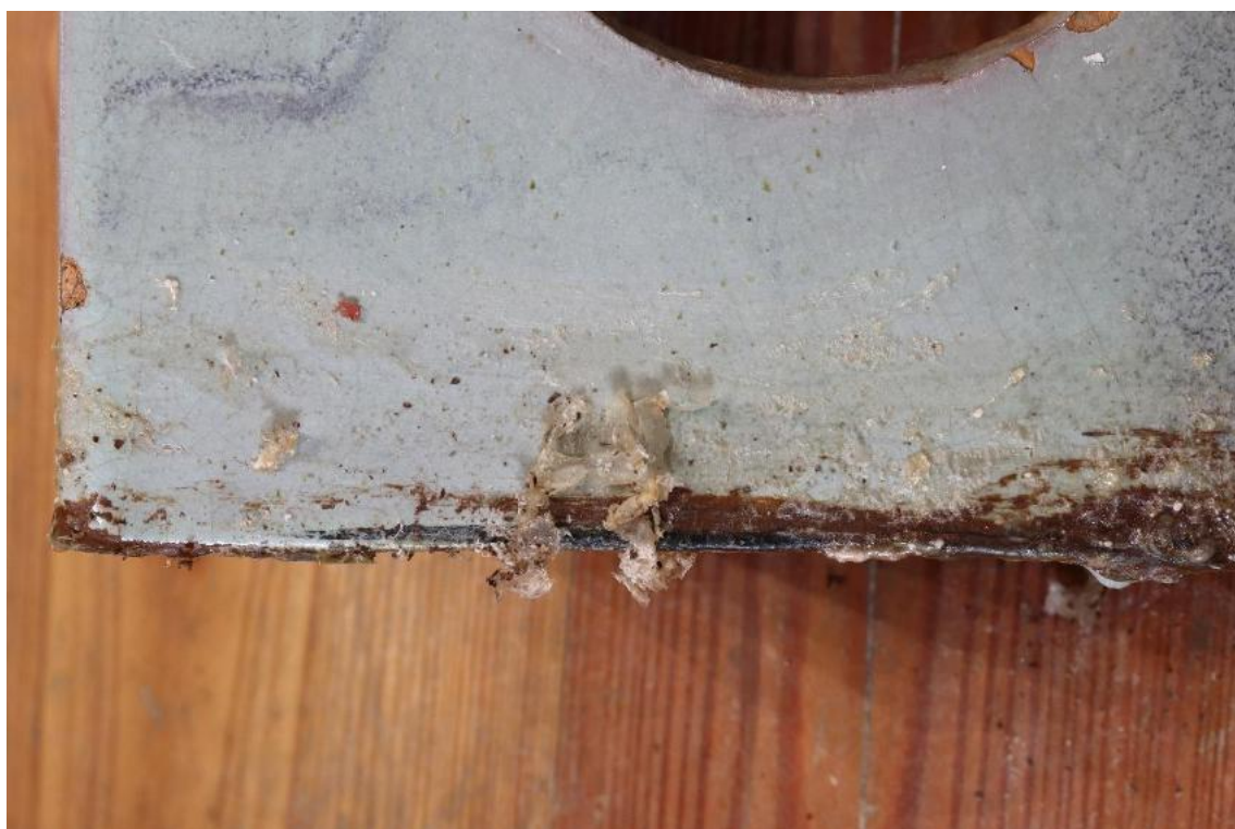
80-81. Čistenie soklovej kachlice od podlahového laku a hnedej farby pomocou odstraňovača starých náterov.
