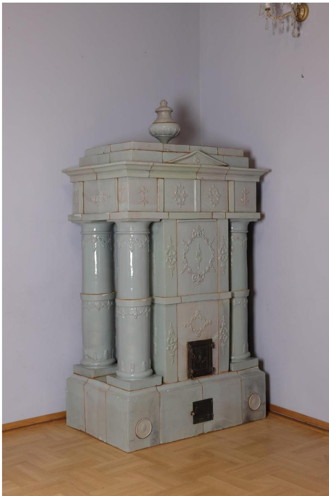
129. Pec po postavení. Je viditeľné škárovanie – to bude ešte farebne upravené.
